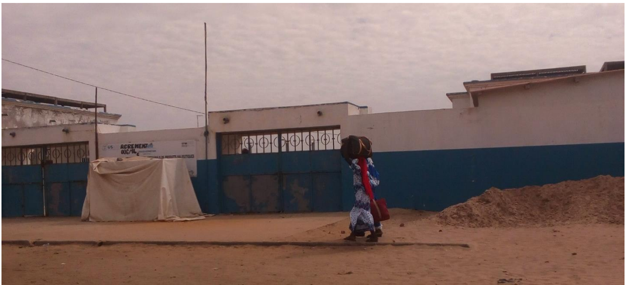
Photo 2: unité moderne de transformation artisanale des produits halieutiques des femmes de Kayar
